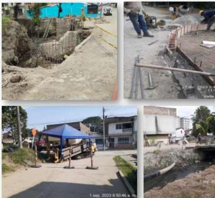
Construcción colector margen izquierda rio Palmira mediante Perforación Horizontal Dirigida - PHD
